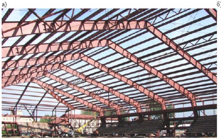
Рис. 1. Продольные ребра в стенках большепролетных рам: а) рамный каркас стадиона «Химик» в г. Кемерово б) узел рамы с продольным ребром в стенке
