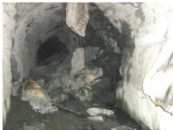
Рис. 3. Нарушения в ортах в результате произошедших микроударов после проведения массового взрыва
