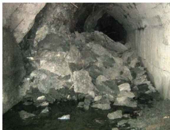
Рис. 3. Нарушения в ортах в результате произошедших микроударов после проведения массового взрыва
