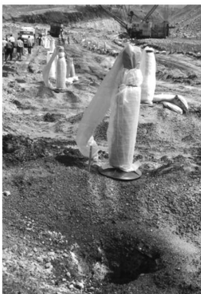
Рис. 8. Устройства подачи рукава, размещенные около скважин на взрывном блоке
