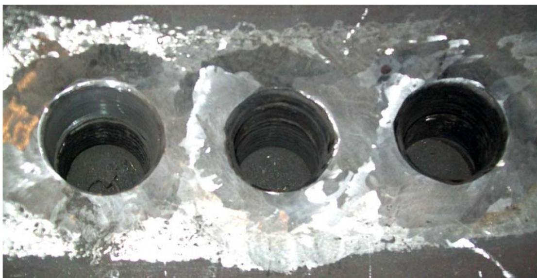
Рис. 1. Водоопускные отверстия после ремонтно-восстановленных работ
