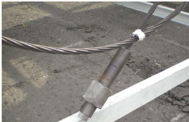
*Рис. 4. Канатный анкер ГАГЗ*
