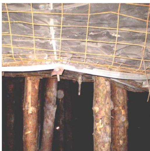
*Рис. 1. Состояние контура и крепи подготовительной выработки, расположенной в сложных условиях*
