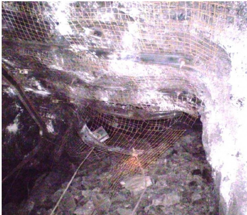
Рис. 1. Обрушение кровли подготовительной выработки, закрепленной анкерной крепью с опорными элементами типа «штрипс» в условиях шахты Талдинская-Западная
