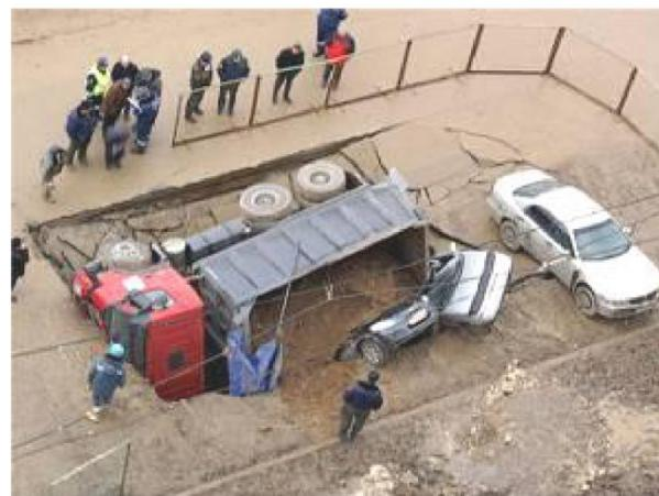
*Рис. 1. Провал дорожного полотна*
