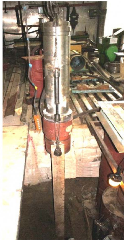
Рис. 4. Погружение двутавровой балки пневмомолотом «Тайфун-150»
