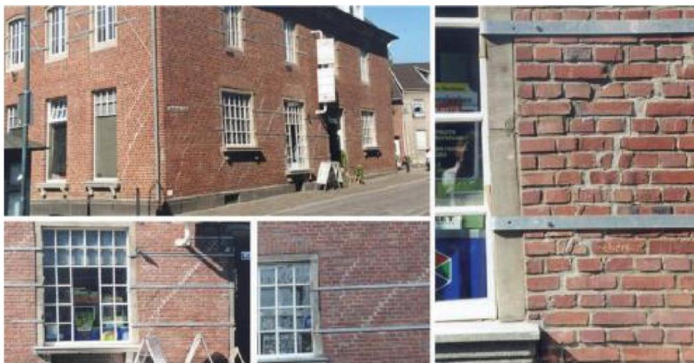
Рис. 3. Образование трещин при пучении грунтов после повышения уровня шахтных вод (Baglikow, 2003)
