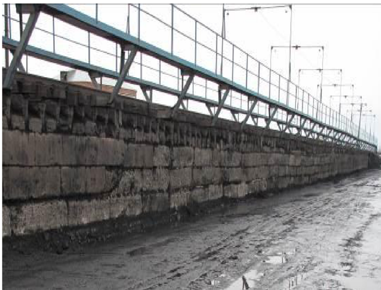
Рис. 1. Внешний вид горно-технической угольной выгрузочной эстакады Fig. 1. The appearance of mining and technology of coal unloading trestle
