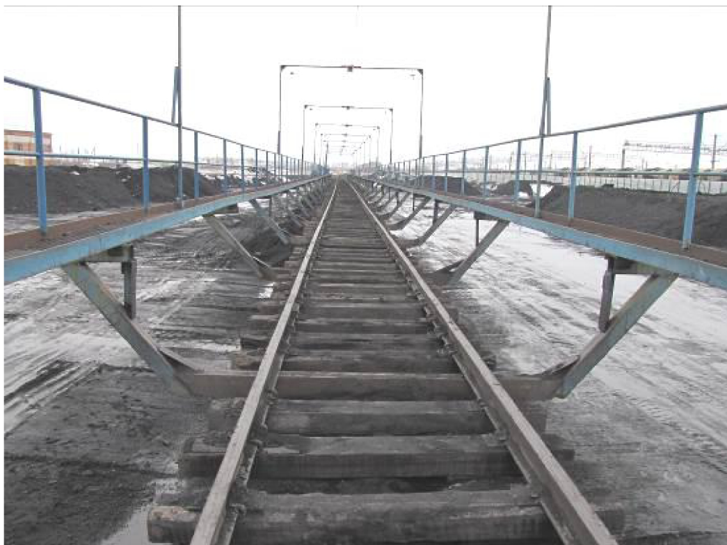
Рис. 2. Конструкция металлических трапов и мачт освещения Fig. 2. The design of the metal bridges and lighting masts
