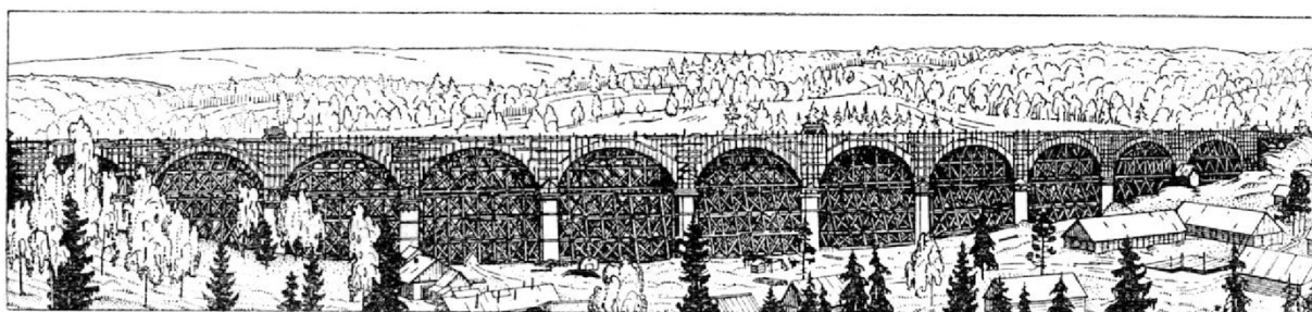
Рис. 6. Бетонный железнодорожный мост (виадук) – «Широкий Лог», построенный в России
