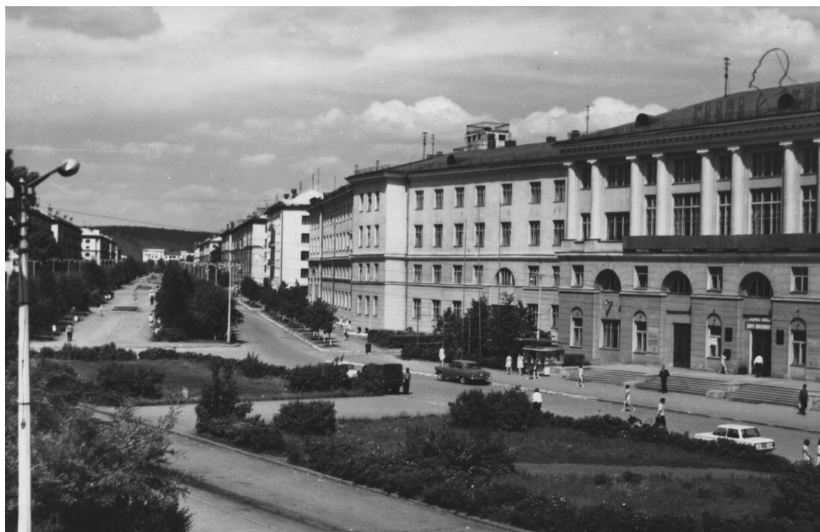
Рис. 8. Новый Главный корпус Кемеровского горного института (фотография 1971 года).
