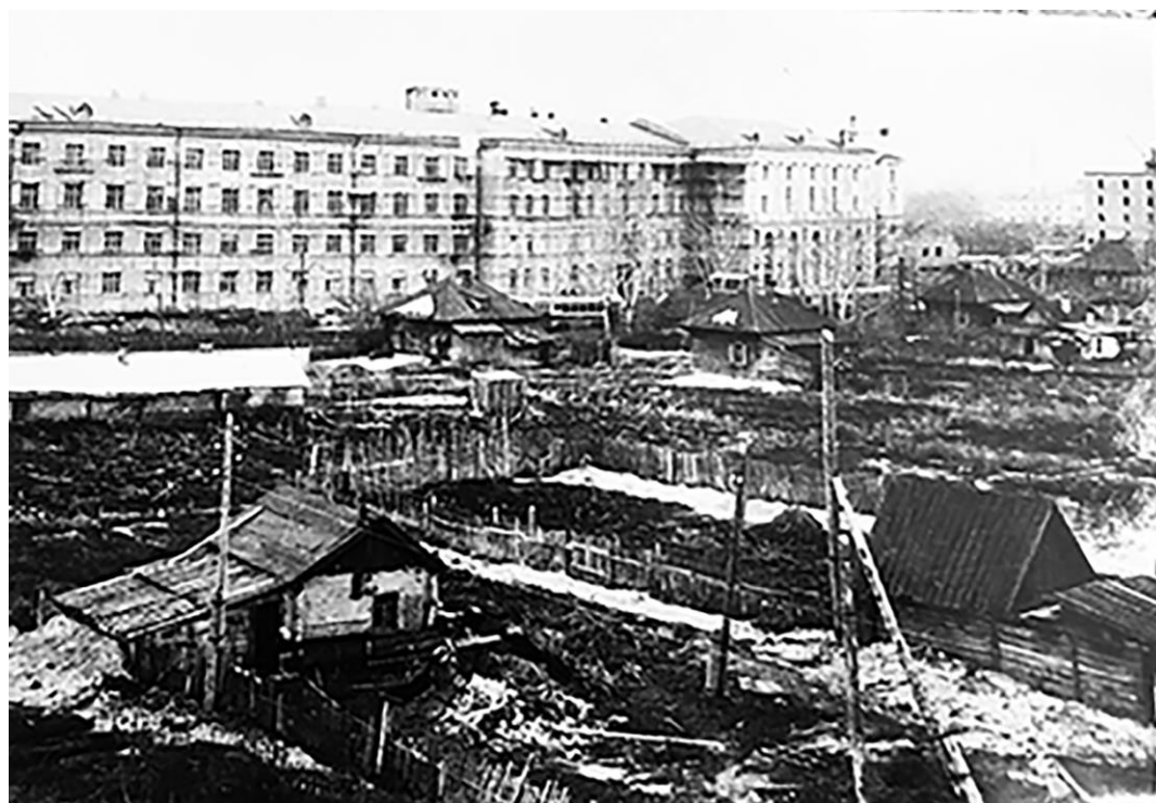
Рис. 7. Окончание строительства Главного корпуса Кемеровского горного института (фотография 1957 года). Fig. 7. Completion of the construction of the Main building of the Kemerovo Mining Institute (1957).
