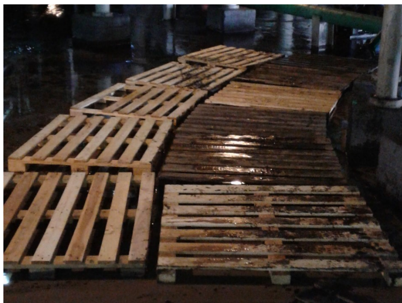
Рис. 2. Установка поддонов Fig. 2. Pallets Installation
