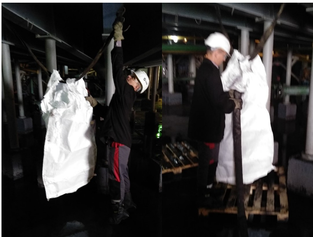
Рис. 4. Вертикальное размещение ОФК: установка и подключение к закачному трубопроводу Fig. 4. Vertical placement of the SFC: installation and connection to the injection pipeline
