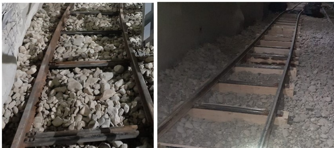
Рис. 3. Установка железнодорожного полотна на почве выработки Fig. 3. Installation of a railway track on the ground of a mine
