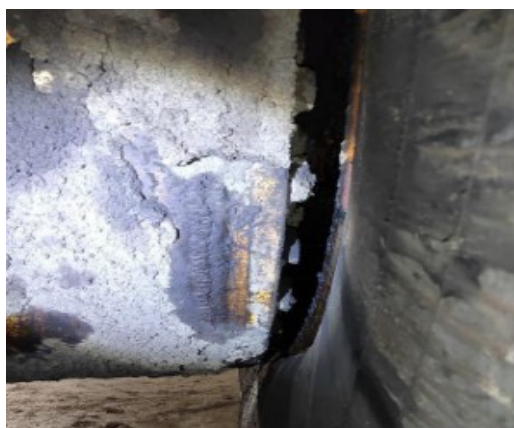
Рис. 4. Трещина на фланце крепления редуктора мотор колеса
