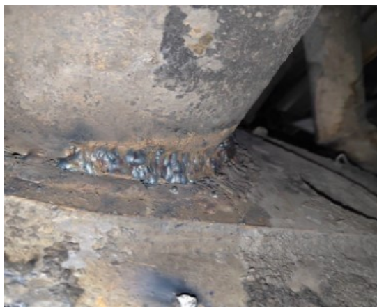
Рис. 3. Трещина в районе крепления центрального шарнира заднего моста
