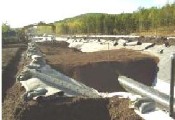
Рис. 3. Водонепроницаемые траншеи
