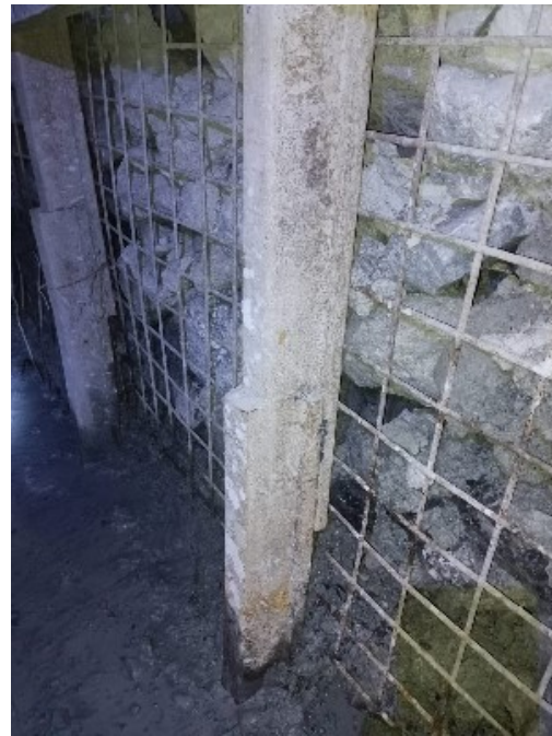
Рис. 1. Удлинение боковой стойки рамной крепи отрезком профиля СВП27 с применением сварки Fig. 1. Extension of the side post of the frame support with a section of SVP27 profile using welding
