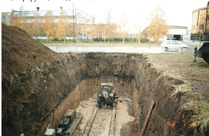
*Рисунок 2 – Бурение подземных скважин-переходов в городских условиях*
