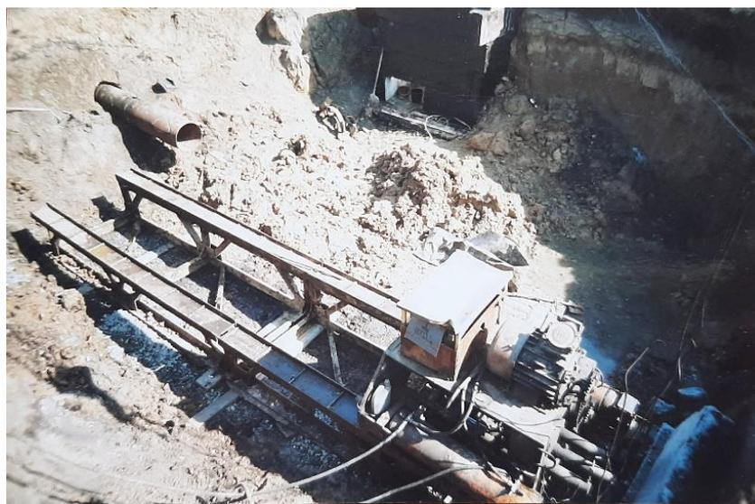
Рисунок 6 – Бурение параллельных скважин инструментом прямого хода
