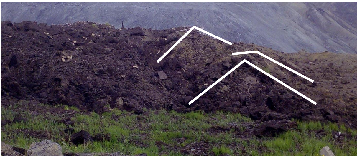
Рисунок 1 – Неотбитые взрывом откосы уступа четвертичных отложений Figure 1 – Unblasted slopes of Quaternary sediment bench
