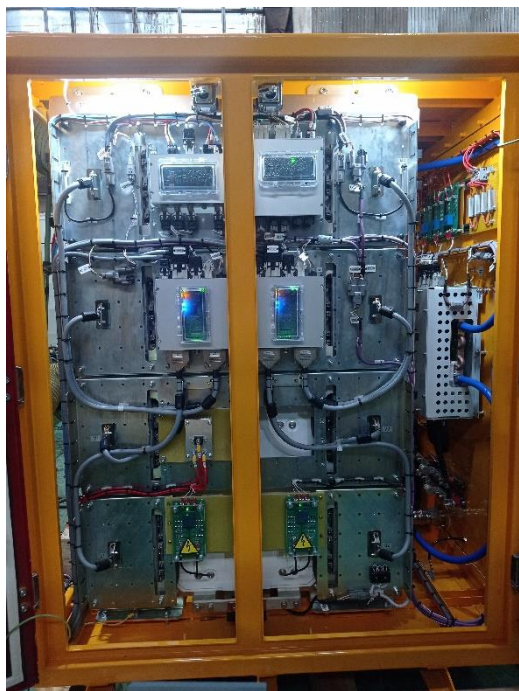
Рис. 4. Расположение блоков управления и защиты ШПСУ
