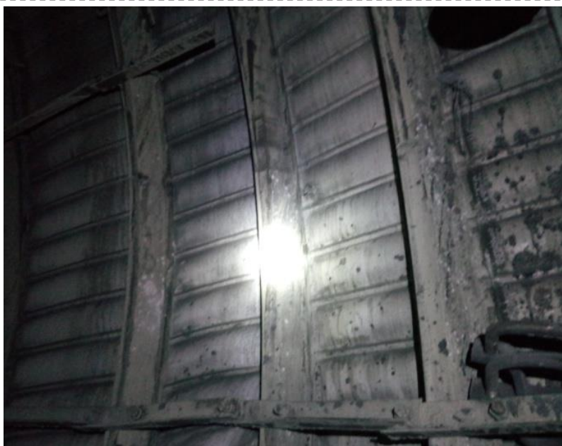
Рис. 1. Вид участка выработки с арочной крепью и тампонажем закрепного пространства с применением фильтрующего армированного полотна на шахте «Анжерская-Южная» Fig. 1. View of a section of the workings with arch support and plugging of the support space using a filter reinforced fabric at the Anzherskaya-Yuzhnaya mine
