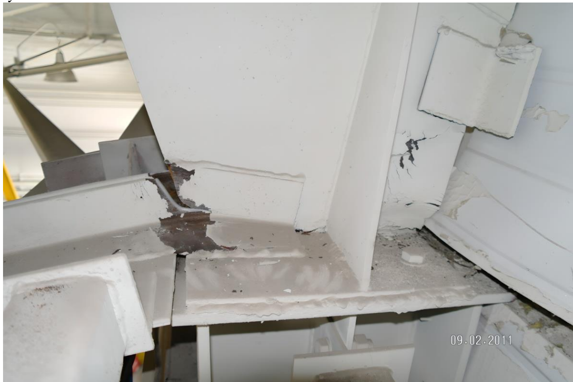
Рисунок 2 – Хрупкое разрушение нижнего пояса фермы
