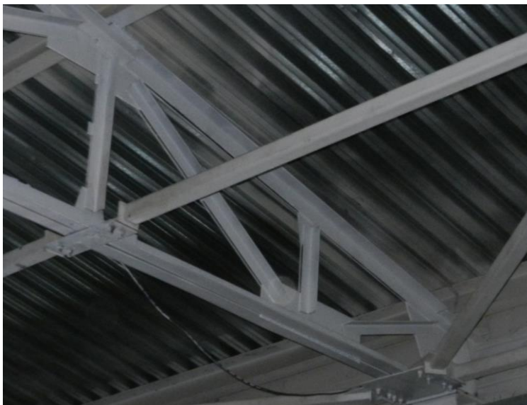
Рисунок 7 – Усиленные фермы: а) общий вид, б) вид опорной панели
