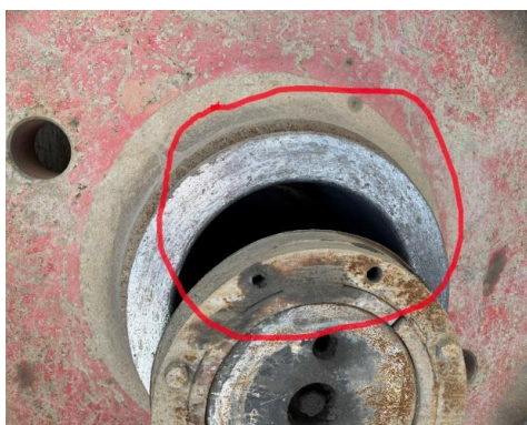
Рис. 2. Критический износ оси натяжного колеса Fig. 2. Critical wear of the tension wheel axle
