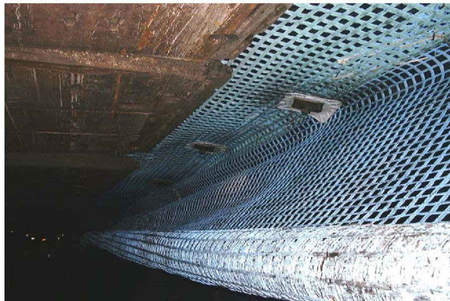
Рис. 6. Начало крепления сетью
